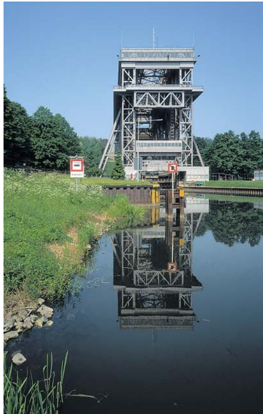
Ansicht des Hebewerkes von der Südseite des Unterhafens
