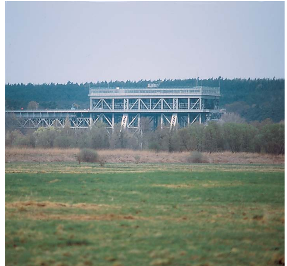
Ansicht des Hebewerkes von der Südseite
