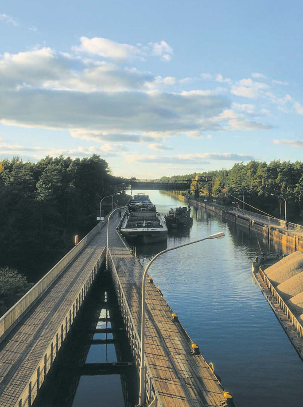
Einfahrt eines Schiffes vom Oberhafen in den Trog des Hebewerkes
