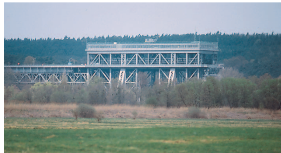
Widok podnośni statków od strony południowej
