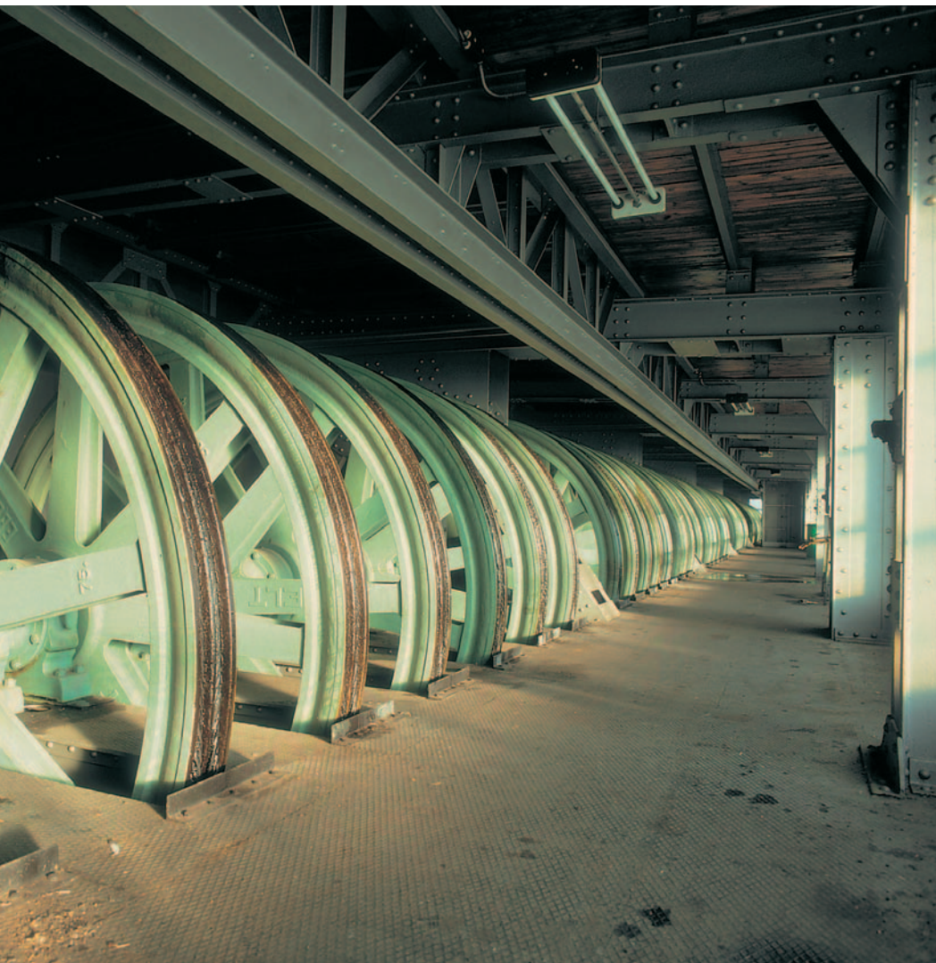
Południowy szereg kół linowych na najwyższej kondygnacji podnośni statków
