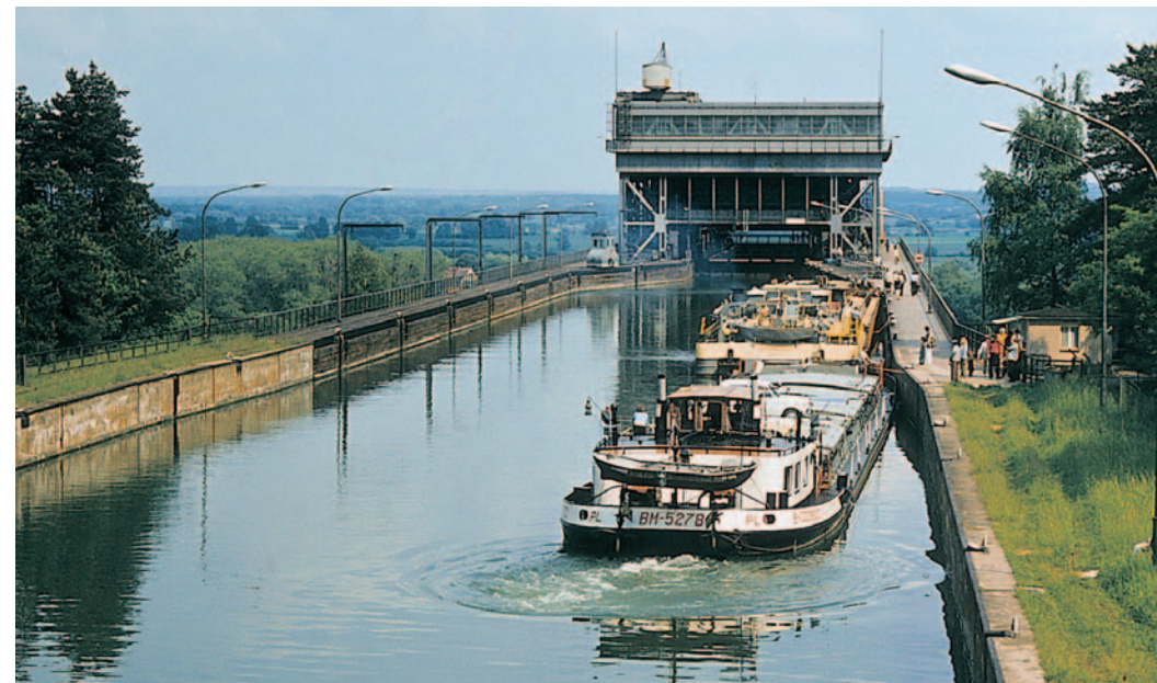
Widok podnośni statków od strony zachodniej
