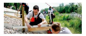
Zu den Aufgaben der Wasserbauerin und des Wasserbauers gehört die bauliche Unterhaltung der Wasserstraßen, Instandsetzung von Anlagen, die Sicherung und Bezeichnung des Fahrwassers bzw. der Fahrrinne für die Schifffahrt und die Inspektion des Gewässerbetts durch Peilungen.
