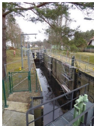
Ansicht von Unterhaupt
