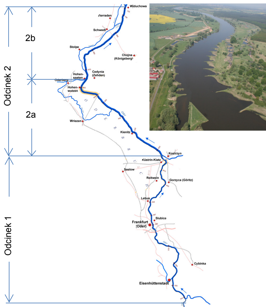
Ilustracja 1-2 Plan poglądowy Odry granicznej i zdjęcie lotnicze Odry z ostrogami i opaską brzegową przy ujściu Nysy Łużyckiej przy m. Ratzdorf (Od-km 542,3 - 545)
